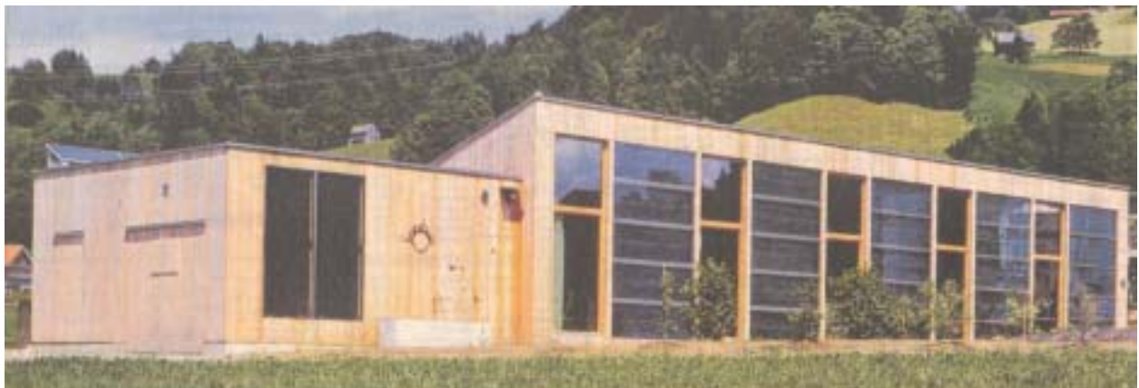
Solarhaus in Ebnat Kappel
