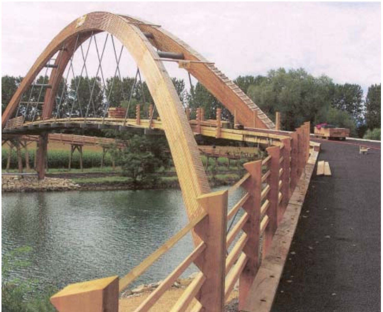
Broye Holzbrücke: Bogenspannweite 60.5 Meter, Höhe des Querwölbers 18 Meter Verwendetes Holz:
