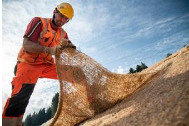
Abb. 4 - Verlegen am Hang. Foto: Lindner Suisse GmbH
