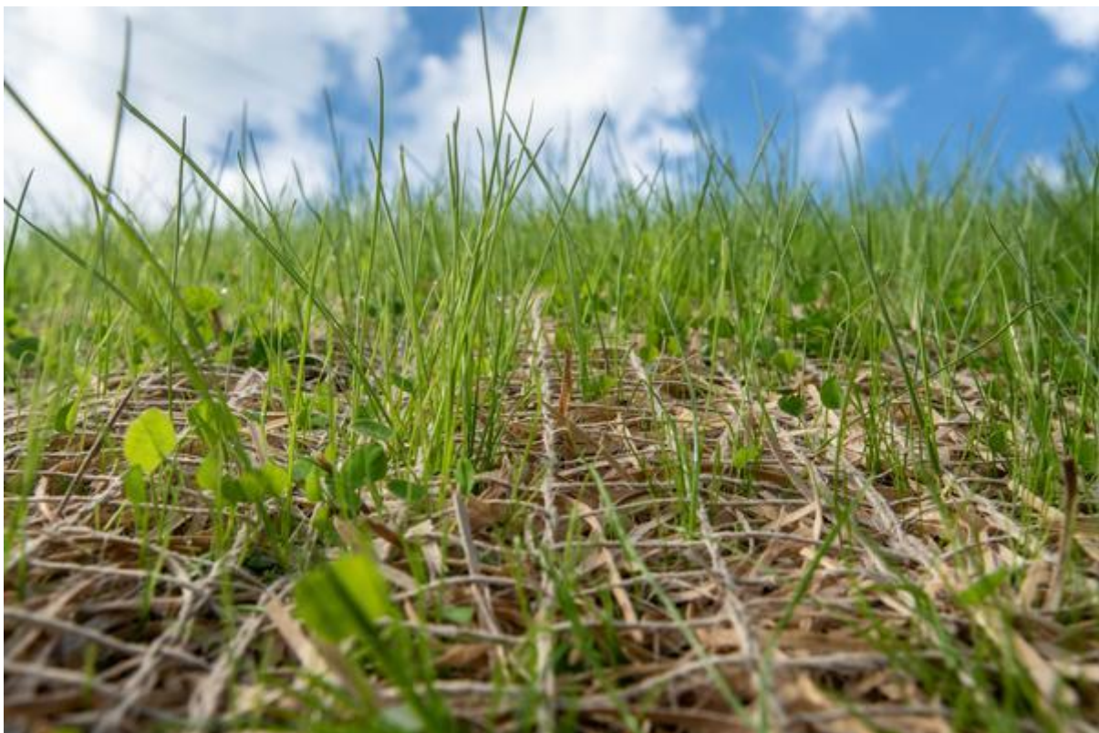
Abb. 1 - Böschungsschutz durch Holzwolevlies. Die Vegetation beginnt zu wachsen.
