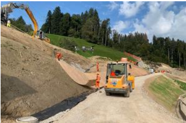
Abb. 5 - Anbringung des Erosionsschutzes aus Holzwolle. Foto: Lindner Suisse GmbH
