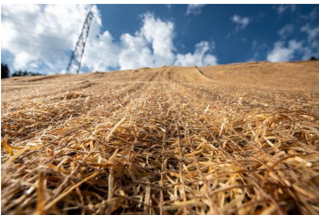
Abb. 7 - Verlegtes Holzwollefließ an einer Böschung. Foto: Lindner Suisse GmbH
