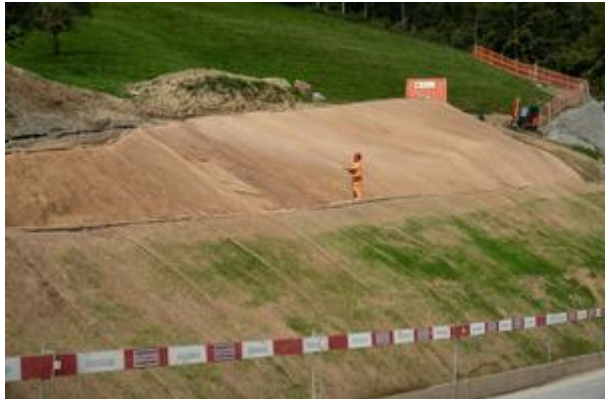
Abb. 6 - Verlegtes Holzwollefließ an einer Böschung. Foto: Lindner Suisse GmbH
