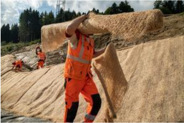
Abb. 3 - Verlegen des Holzwollefließes ab der Rolle. Foto: Lindner Suisse GmbH
